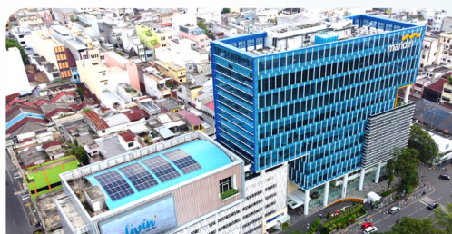
MENARA BANK MANDIRI MEDAN - 50 KWP
